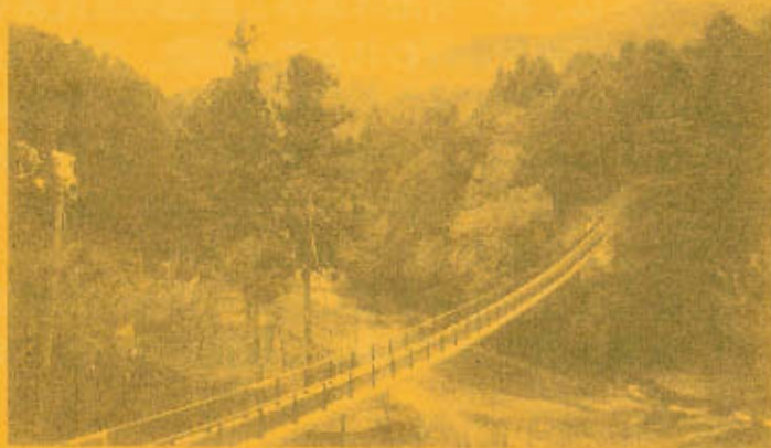
温浴施設へ至る観光吊り橋
